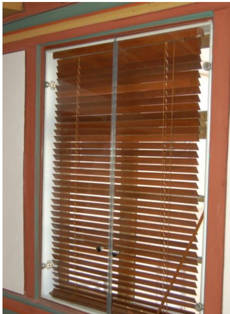
„Sulmeisterburg“ in Schwäbisch Hall Beispiel für volltransparentes Kastenfenster (Doppelfenster) von innen
