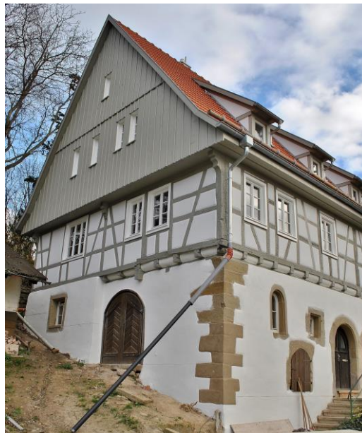
„Spatznehof“ in Ellhofen Giebel- und Dachdämmung entsprechen Niedrigenergistandards
