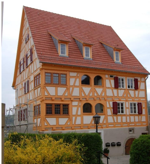
Keltergasse 5 in Neudenu Dachdämmung entspricht KfW-Effizienzhausstandard
