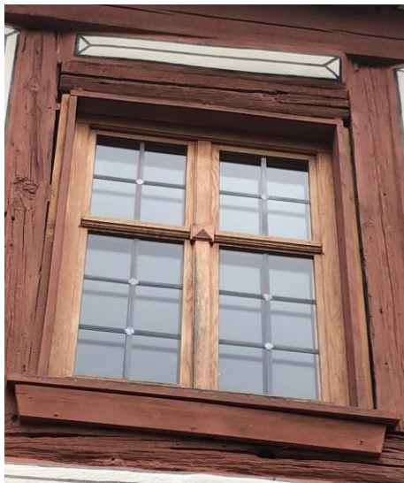
Ehemaliges 'Siechenhaus' in Gaildorf Beispiele für neue Verbundfenster in bautypologisch passender Gestaltung
