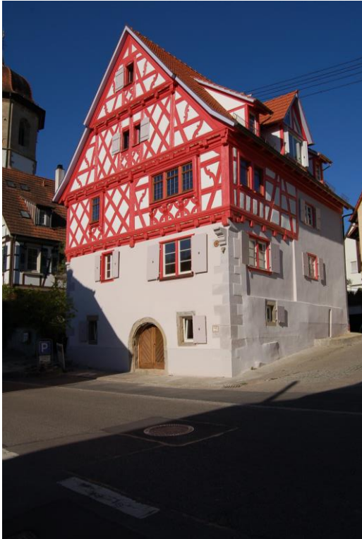
Hauptstraße 20 in Oberriexingen Alle Fenster sind Isolierverglast Das Dach ist mit 22cm Wärmedämmung aufgebaut und erfüllt EnEV-Richtwerte
